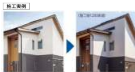
施工後12年が経過してもこの美しさ。汚れが目立たず、新築時の美しさを長期間にわたって保ちます。
